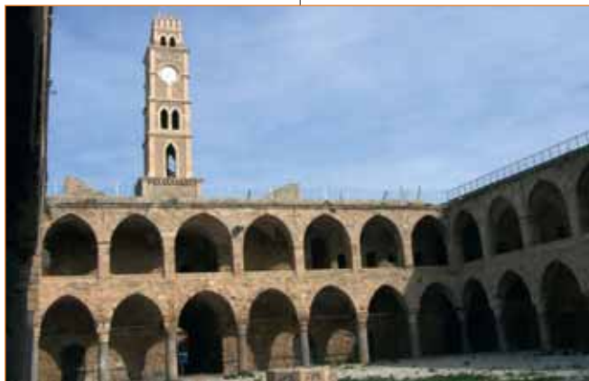
Akko - Caravanserraglio delle Colonne
